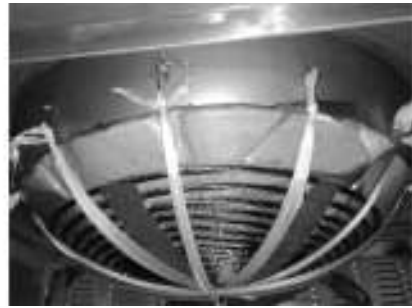
图5 试验后完好无损的重要部件
