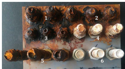
图5 加速试验2500 h后不同涂层紧固件表面腐蚀形貌
