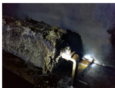
c 压载舱底部
