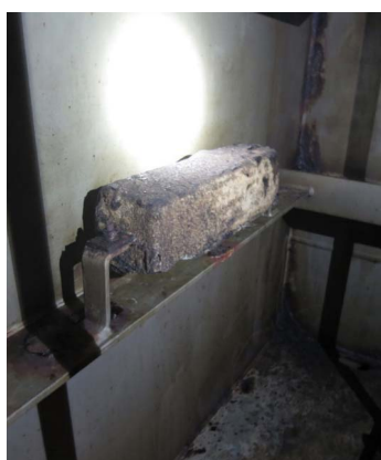
a 压载舱上部
