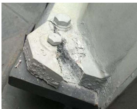
c 吊装螺孔处
