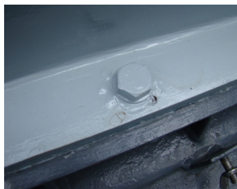
d 螺栓安装处
