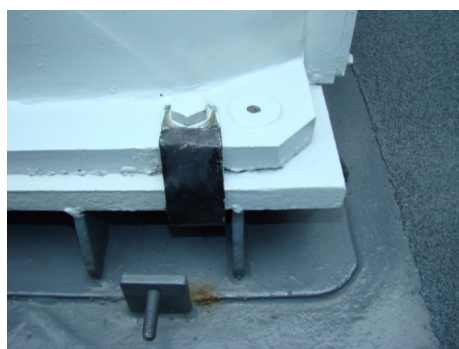
a 安装结合处
