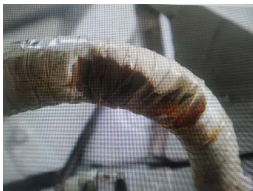
图2 直升机中热渗锌紧固件的腐蚀
